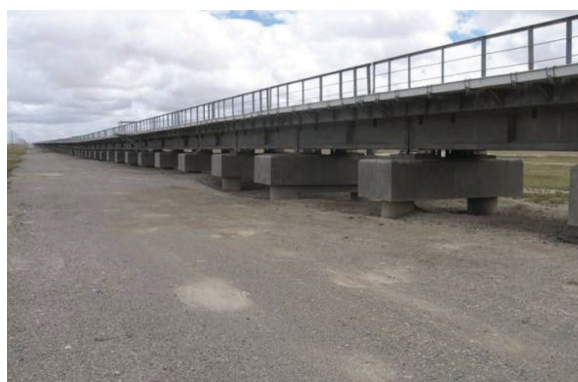
2.8.12-сурет. Жерге арнайы тереңдетілген тіректердегі жолдар.
